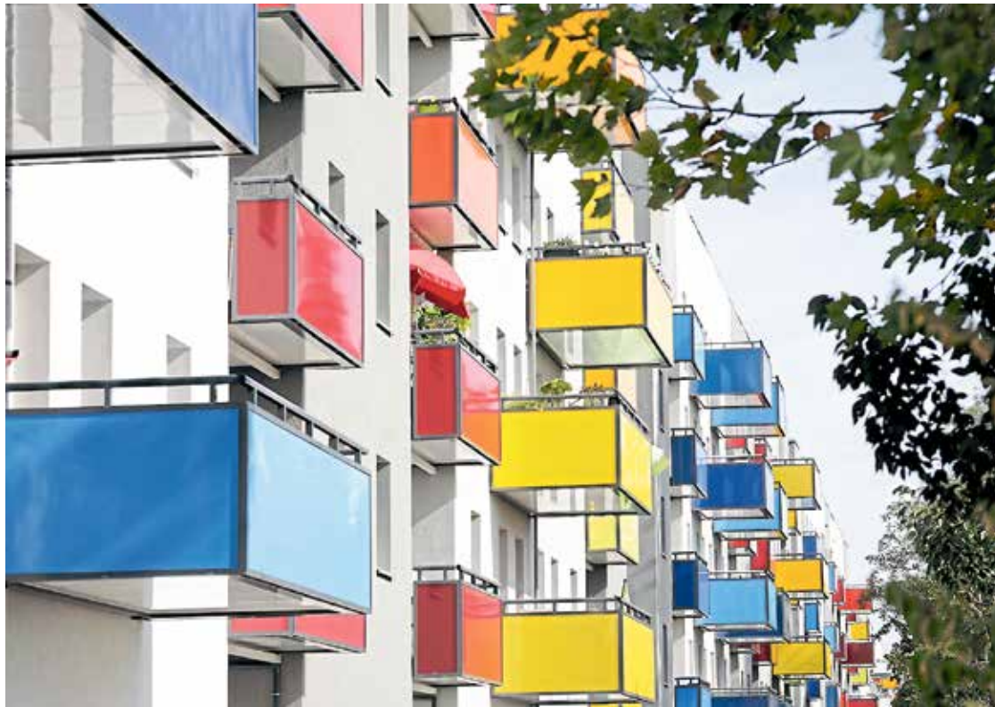
Sanierte Wohnungen in Potsdam-Drewitz. Bis zum Jahr 2050 soll, so das Ziel der Bundesregierung, der Gebäudebestand nahezu klimaneutral werden.
