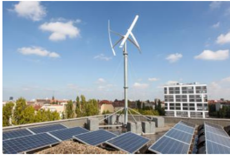
Erzeuger (81 kWp PV – 6 kW Wind)
