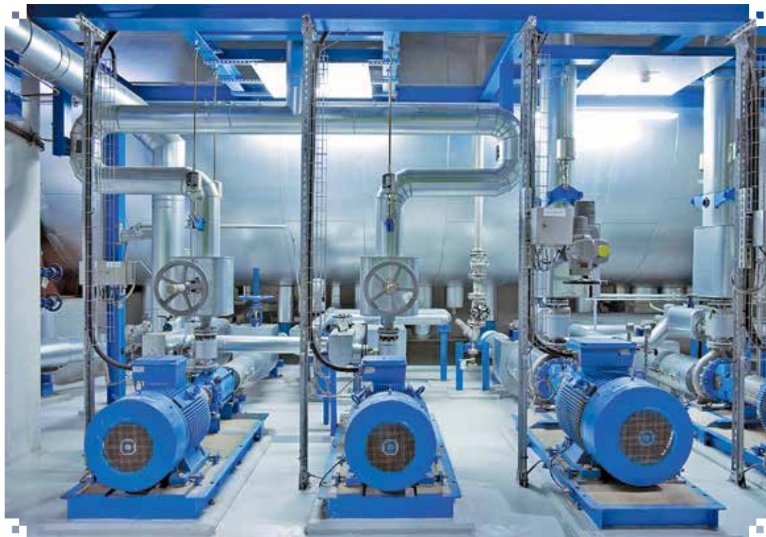
In dem modernen Heizkraftwerk der Bonner SWB wird Fernwärme hocheffizient unter Nutzung der Kraft-Wärme-Kopplung bereitgestellt. Das bringt einen erheblichen Beitrag zum Klimaschutz.
